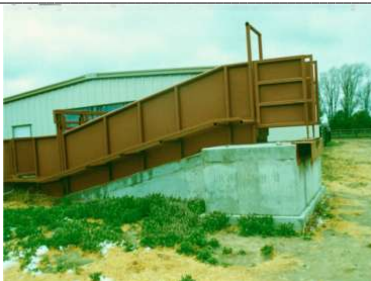
DETALHE DA RAMPA DE CARREGAMENTO
